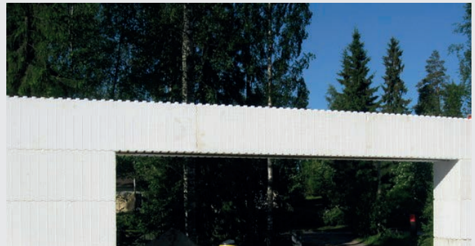
Kuva 10: FinnEPS-harkolla on helppo toteuttaa myös suuret aukkojen ylitykset.
