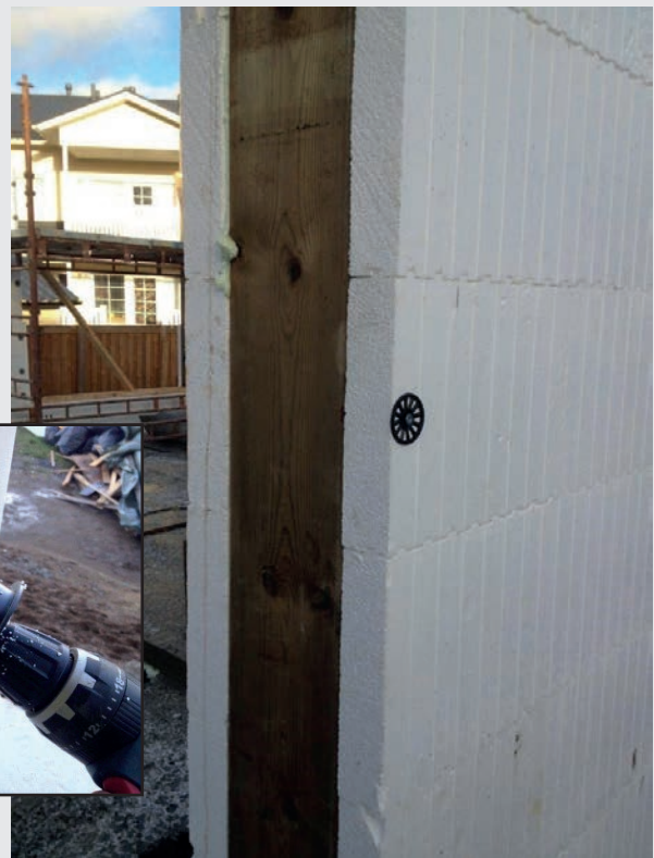
Kuva 18: Esimerkki kiinnitystavasta FinnEPS-avoharkolla toteutettuun aukkoon.
