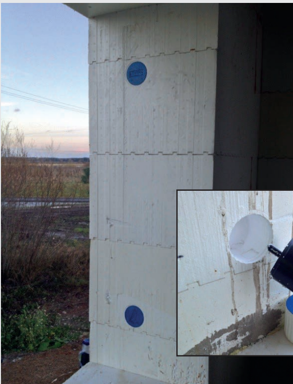
Kuva 17: Esimerkki kiinnitystavasta FinnEPS-päätyharkolla toteutettuun aukkoon.
