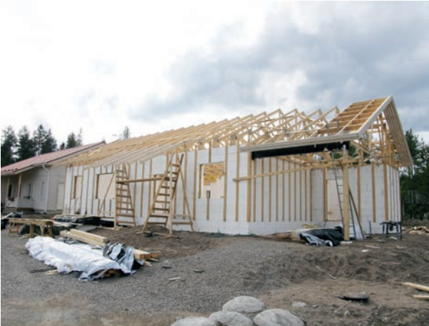
Kuva 23: Kiinnitysjuoksut puuverhoukselle.
