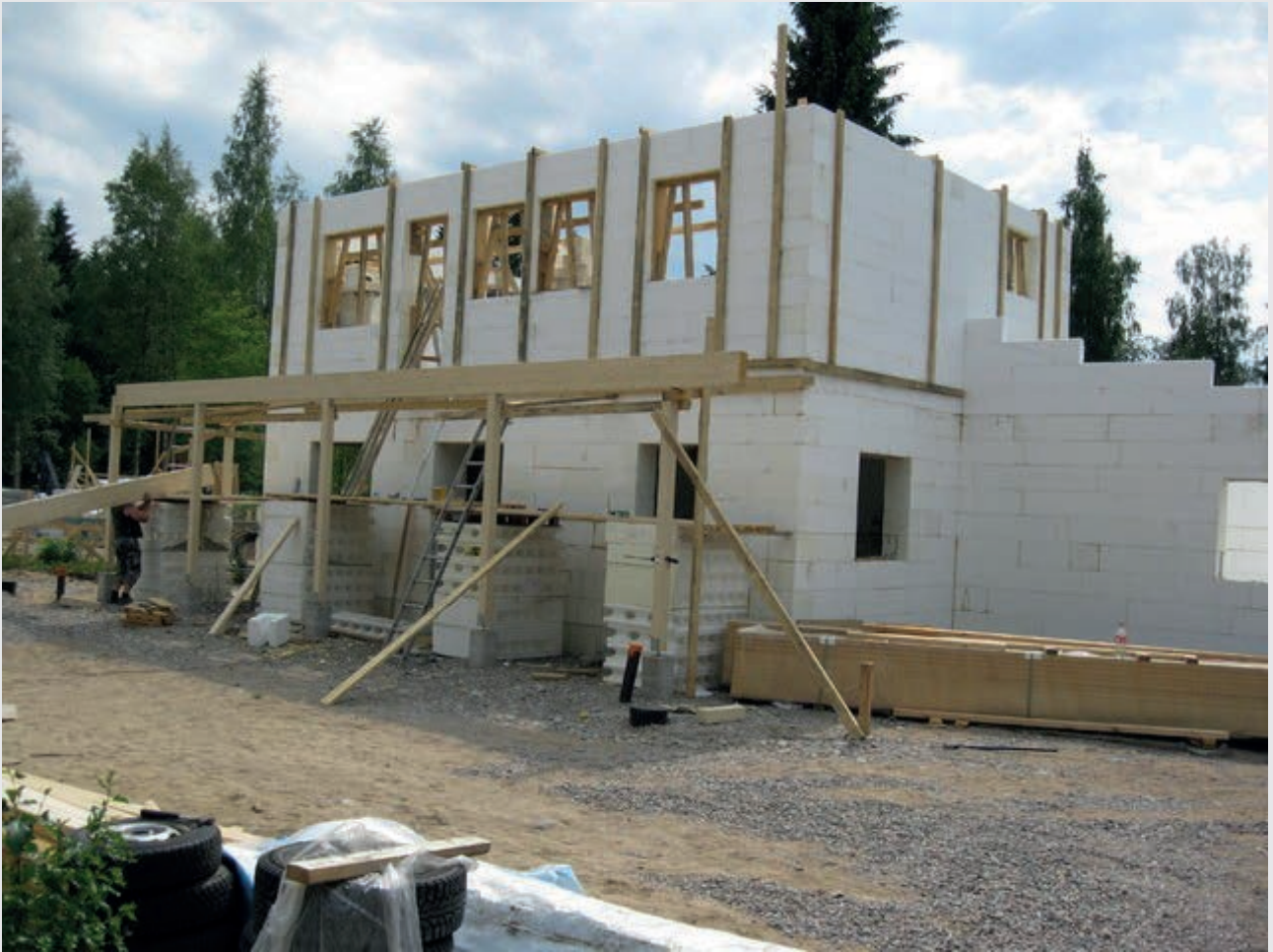
Kuva 15: Esimerkki toisen kerroksen seinärakenteen tuennasta.
