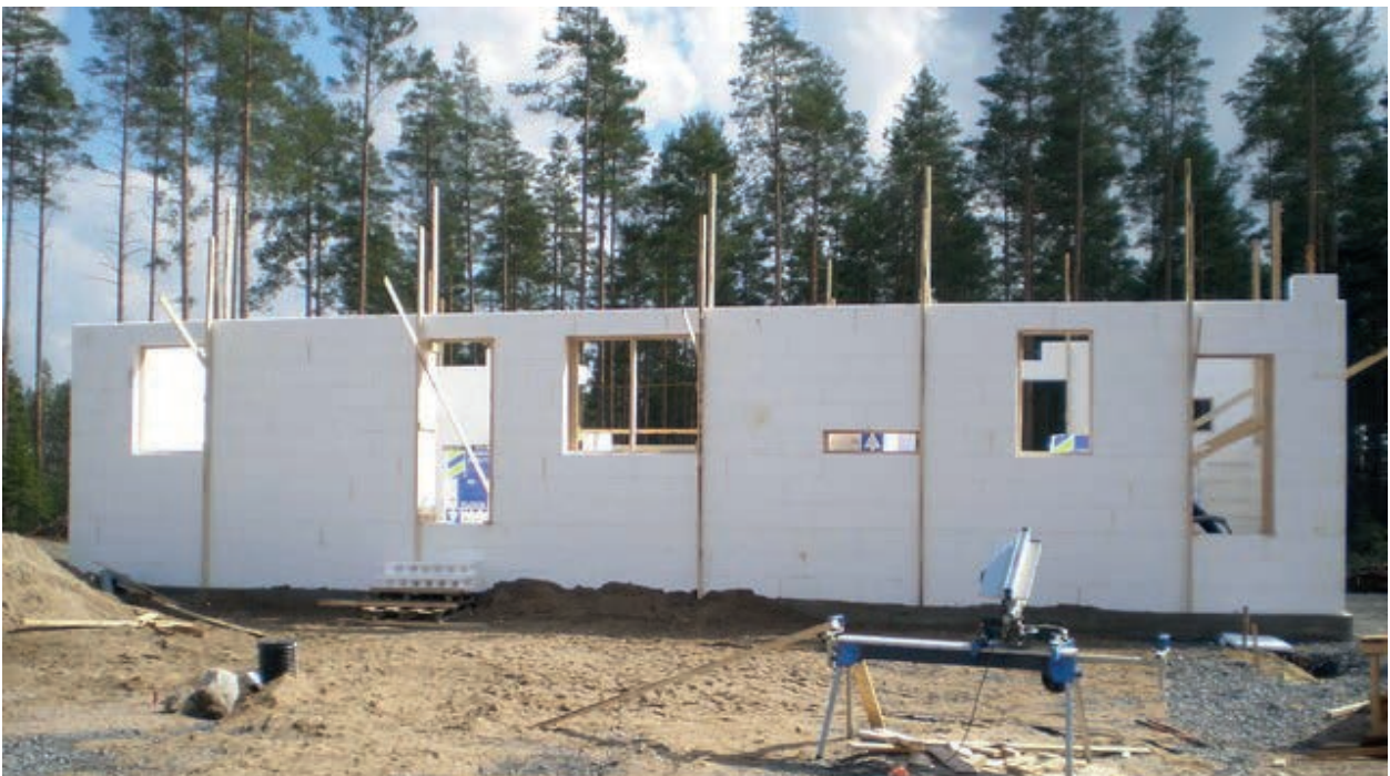
Kuva 14: Esimerkki suoran seinärakenteen pystytuennasta sekä aukkojen tuennasta.
