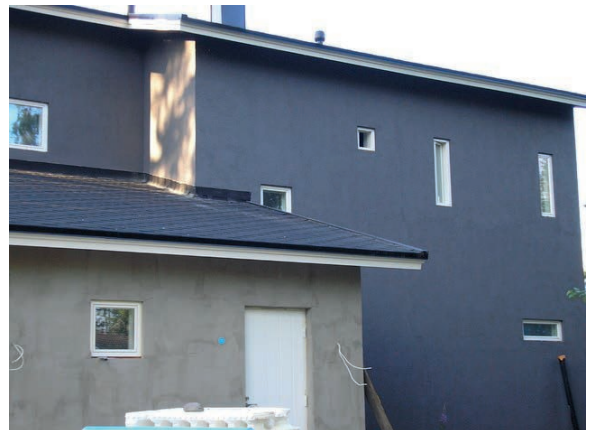
Kuva 21: Valmis rapattu FinnEPS-harkkoseinäpinta sekä pohjarapattu pinta.
