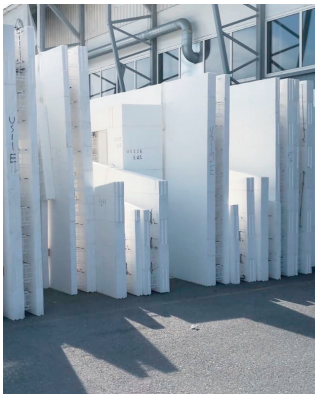
FSE Elementtien asennus
