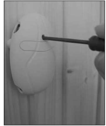
Kuva 11. Ylikuumenemissuojan palautuspainike Bild 11. Överhettningsskyddets återställningsknapp
