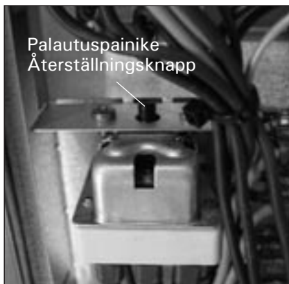
Kuva 3. Ylikuumenemissuoja Bild 3. Överhettningsskydd
