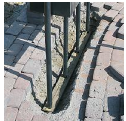
Jalustaputkien alle laitettu kesto-putkilaudoitus voi auttaa ryhmän
