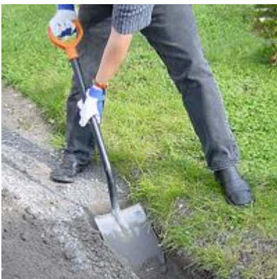
Asennuspaikkaan kaivetaan lapionlevyinen, n. 40 - 50 cm syvä ura.
