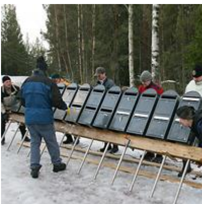
Valmiksi koottu postilaatikkoryhmä nostetaan asennuspaikalle.
