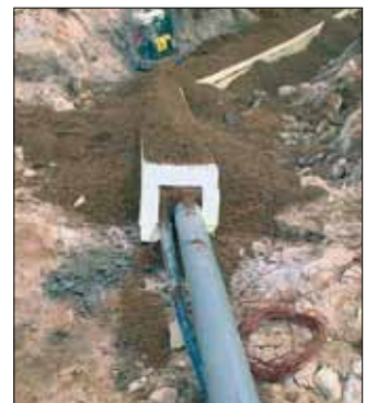
Finnfoam-putkikotelosta valmistetaan helposti lämmönvaihdin, jolla jätevedestä saadaan osa lämmöstä talteen. Sadevesiputki asennetaan kotelon ulkopuolelle, mutta Finnfoamin alle. Näin suojataan sadevesiputkea jäätymiseltä.
