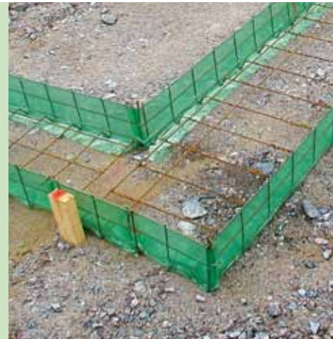
Kulmapalat voidaan taivuttaa haluttuun terävytyteen. Sidonta on tehtävä huolella koska valupaine kohdistuu juuri kulmiin ja T-liitoksiin.
