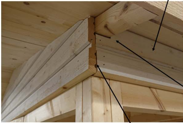
Sivuseinän ylä peittolaudat, molemmin puolin rakennusta räystäään alle kaksi lautaa
