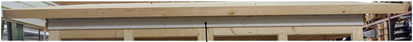
Sivuseinän ylä peittolaudat, molemmin puolin rakennusta räystäään alle kaksi lautaa
