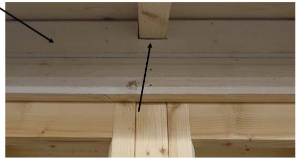
Ylemmässä peittolaudassa on valmiit sovitukset kattotuolien kohdalla
