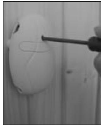
Kuva 14. Ylikuumenemissuojan palautuspainike Bild 14. Återställning av överhettningsskydd
