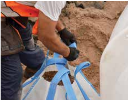
Pujota liina täytettyjen ja puhdistamon viereen siirrettyjen ankkurointipussien silmukoiden läpi.
