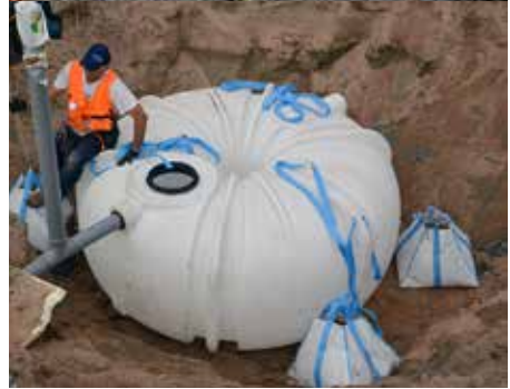
Ankkuroi umpisäiliö vähintään neljästä eri kohdasta.
