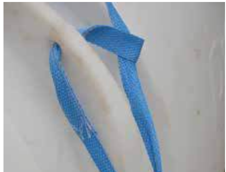
Pujota liina umpisäiliön ankkurointikorvan läpi.
