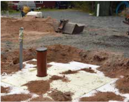
Eristä kaivanto ja viemäriputki routaeristelevyllä.
