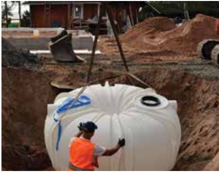
Säiliö nostetaan ankkurointikorvista liinoilla.
