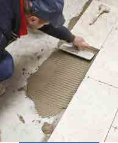
Luonnonkivien asennus ulkotiloissa
