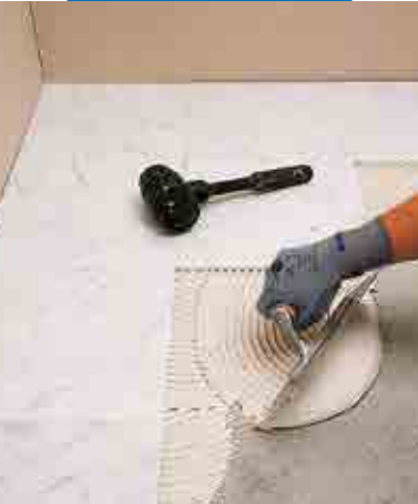
Valkoisen Carrara-marmorin kiinnitys valkoisella Keraquick S1-laastilla
