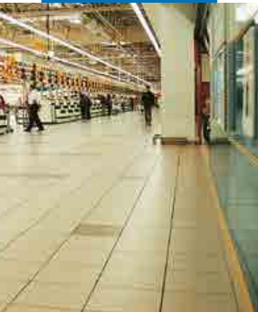
Keraquick S1-asennus, supermarketin lattia, Auchan, Sosnowiec, Puola
