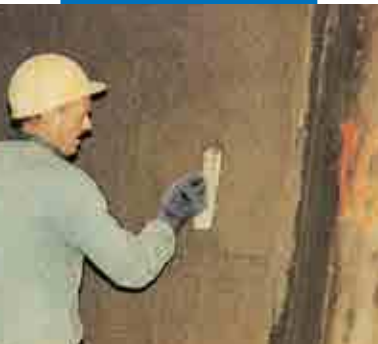
Planicrete-rappaus - Ville Marie -moottoritien tunneli, Montreal, Kanada
