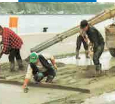
Planicrete-betonin valu ulkotiloissa - Vieux Port, Quebec, Kanada
