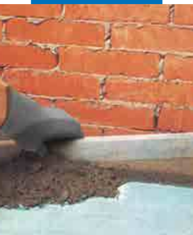
Planicrete-modifioidun pintavalun asennus
