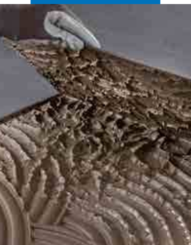
Ohuen porcellanato-laatan kiinnityslaastikerroksen tarkastus
