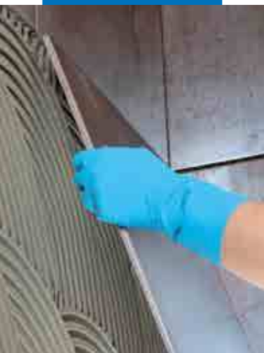
Isokokoisten laattojen kiinnitys seinään
