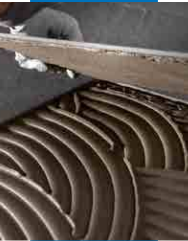
Ohuen porcellanato-laatan kiinnitys lattiaan
