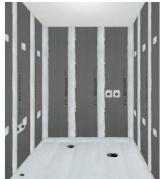
Vedeneristä lattia Mapegum WPS -järjestelmän mukaisesti.
