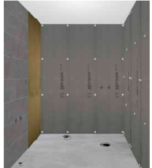
Seinän levytys laastipeittomenetelmällä.
