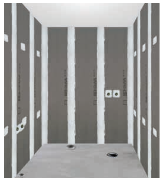
Sivele vedeneristettä nauhojen ja läpivientikappaleiden päälle.
