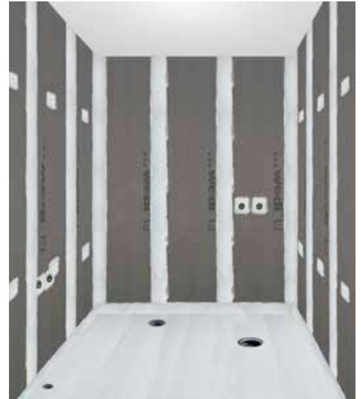
Vedeneristä lattia Mapegum WPS -järjestelmän mukaisesti.
