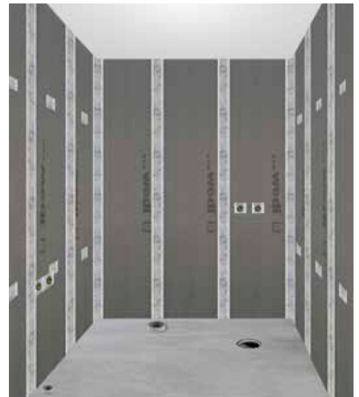
Tiivistä läpiviennit ja kiinnikkeiden kannat.
