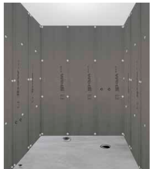
Vahvista kiinnikkeillä heti asennuksen edetessä.
