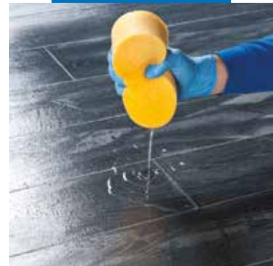
Saumatus laatoituksen kastelu ennen puhdistamista
