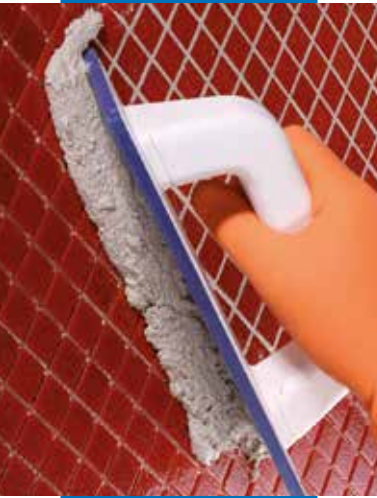
Kerapoxy Design -massan asennus kovakumilastalla
