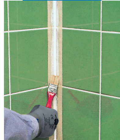
Sauman muotoilu saippuavedellä ja siveltimellä
