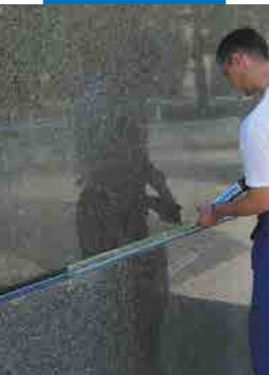
Julkisivusauman tiivistys Mapesil LM
