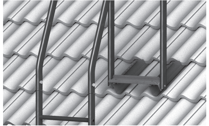
Kuva 16. Yläkaaren liitos tiilikattoon.
