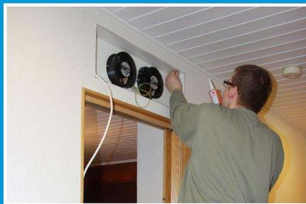
Kun koneikko on asennettu aukkoon, tiivistetään seinärakenteen ja läpivientikanavan raja. Puhallussuunta lämmitettävään / jäähdytettävään huoneeseen päin.
