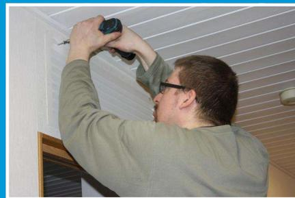
Gallren fästs på plats och installationen är färdig. Gallret installeras så att luftflödet riktas mot taket. Om innerdörren inte hålles öppen bör man installera ett luftgaller i mellanväggen eller i dörren.
