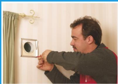
Efter att luftintagsröret och yttergallret installerats fästs installationsramen på innerväggen. Om öppningen är större än anläggningen kan en underlagsskiva installeras.
