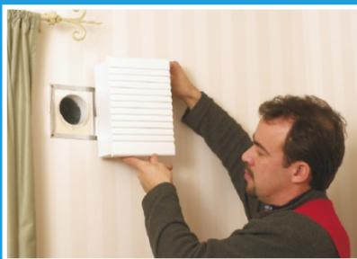
Intagsluftanläggningen trycks mot installationsramen, där den samtidigt lägger sig tätt mot väggytan och ingen anslutning till luftintagsröret behövs. Elanslutning antingen fast eller med stickpropp.
