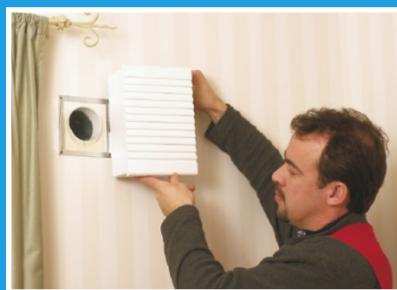
Laite painetaan kiinni asennuskehykseen, jolloin se samalla tiivistyy seinäpintaa vasten, liitosta ulkoilmaputkeen ei tarvita. Sähkökytkentä voi olla kiinteä tai pistotulppakytkentä.
