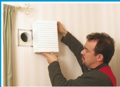
Intagsluftanläggningen trycks mot installationsramen, där den samtidigt lägger sig tätt mot väggytan och ingen anslutning till luftintagsröret behövs. Elanslutning antingen fast eller med stickprop.
