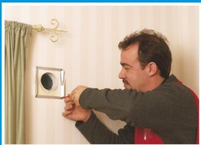
Efter att luftintagsröret och yttergallret installerats fästs installationsramen på innerväggen. Om öppningen är större än anläggningen kan en underlagsskiva installeras.
