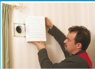
Laite painetaan kiinni asennuskehkyseen, jolloin se samalla tiivistyy seinäpintaa vasten, liitosta ulkoilmaputkeen ei tarvita. Sähkökytkentä voi olla kiinteä tai pistotulpapaketykentä.
