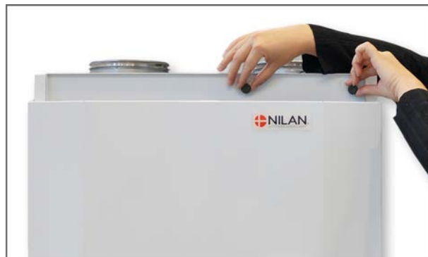
2. 2. 2. Avaa sormiruuvit laitteen oikeasta yläkulmasta ja avaa luukku
