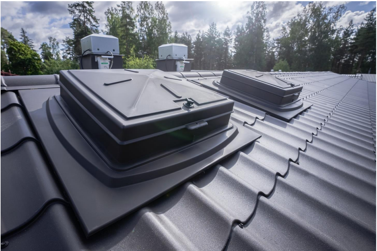
Kuvat 11. Plastec kattoluukku asennettuna tiilikuviopellille
