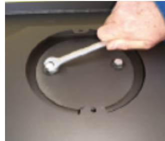
6. Tulppaa yläosan hormliiäntä. Kiristä pulteilla
