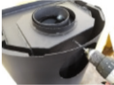
2. Toista taemmalle osalle. Varmista ettei kansi putoa tulisijan ja sen ulkokuoren väliin
