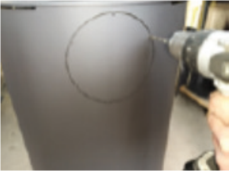
1. Poraa 3 mm:n reikiin 6 mm:n poranterällä. Irrota kansi.
