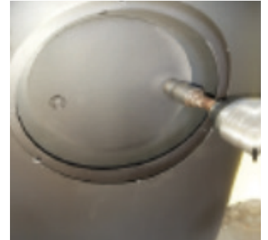
3. Löysää savuaukon tulpan kahta mutteria ja irrota se
