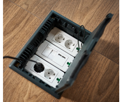
Lattiarasia L 6 moduulin asennuksessa.
