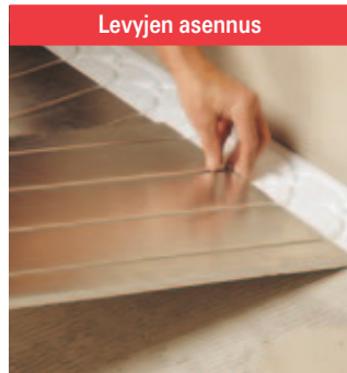
T2Reflecta-levyt voidaan liimata aluslattiaan...
