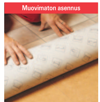
Asenna muovimaton alustaksi aluskartongin tai -muovin päälle vielä 6 mm paksu kovalevy tai lastulevy, johon matto kiinnitetään valmistajan ohjeiden mukaan.
