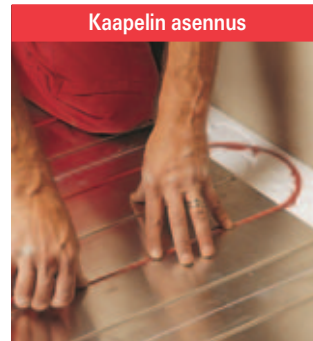
T2Red-lämpökaapeli kiinnitetään eristettyjen T2Reflecta-levyjen uriin. Lämmitysteho määräytyy kaapelin asennusvälin perusteella.
