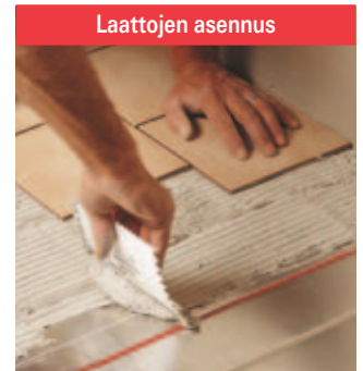
Laatat asennetaan asennusohjeen mukaan suoraan T2Reflecta-levyjen päälle. Pääset nauttimaan mukavan lämpimästä lattiastasi jo noin vuorokauden kuluttua laattojen saumauksesta.
