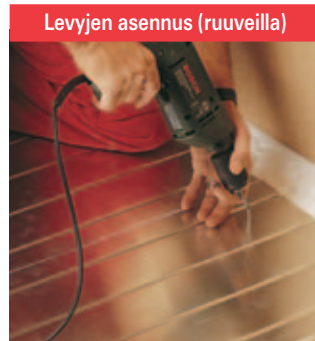
...tai kiinnittää ruuvein erikoisohjeita noudattaen.
