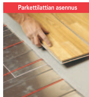
Peitä T2Reflecta-levyt aluskartongilla tai -muovilla ja asenna parketti- tai laminaattilattia valmistajan ohjeiden mukaan.
