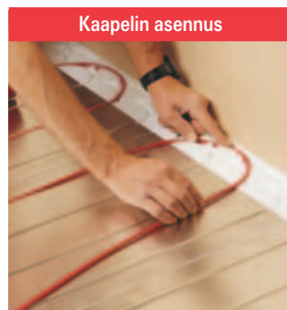
Asettele T2Red-lämpökaapeli levyjen uriin. Lämmitysteho määräytyy kaapelin asennusvälin perusteella.
