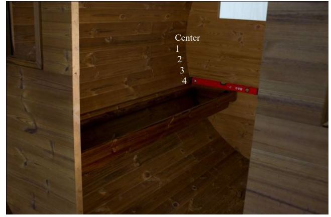
Irrota istuinosa kehikosta ja sijoita kehikko saunaan, käytä vesivaakaa, että saat sen suoraksi. Istuin sijoitetaan neljä sivulautaa alle keskilaudan.
