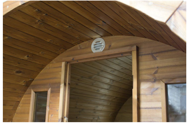
Ruuvaa kiinni tuuletusventtiili.
