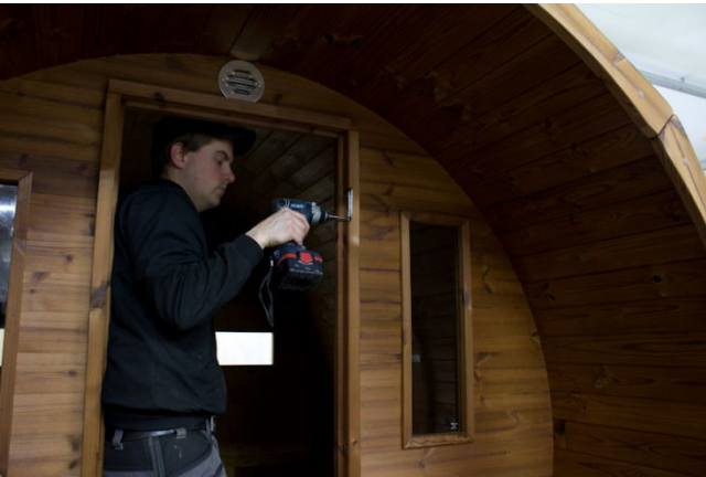
Ovi asennetaan viimeiseksi. Kiinnitä saranat niille merkattuihin kohtiin, 25mm + saranat.
