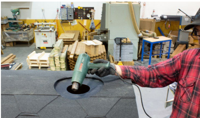
Käytä kuumailmapuhallinta liiman aktivoimiseen
