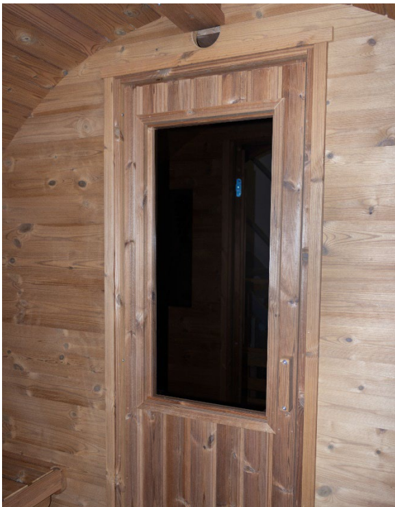
Ovi asennetaan viimeiseksi. Kiinnitä saranat niille merkattuihin kohtiin, 25mm + saranat.
