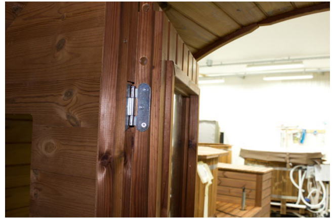
Ruuvaa kiinni ovi ja kahvat.
