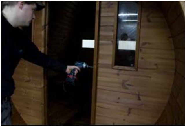
Aseta karmi oviaukkoon ja ruuvaa se kiinni (ruuvireiät merkattuina, 55 mm).
