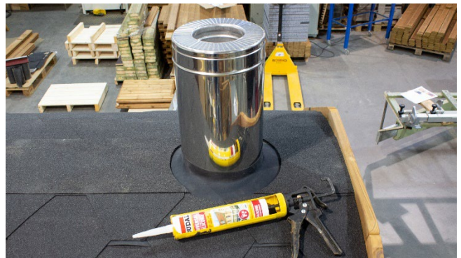
Nosta savupiippu sisäpuolelta
