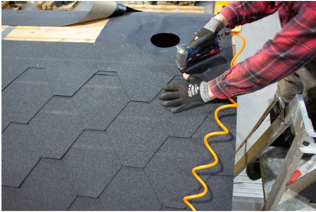
Laita loput kattuhuopaosat.
