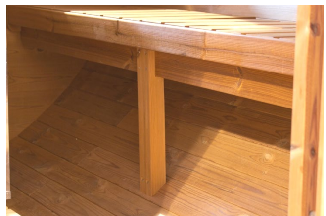
Asenna tukijalka 1 kpl/sivu. HUOM! Tukijalkojen pituutta voi joutua korjaamaan paikan päällä riippuen siitä kuinka tarkasti istuin kehys on asennettu.
