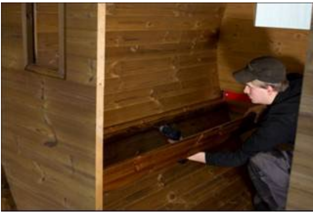
Ruuvaa kiinni istuinkehikko (ruuvinreiät merkattuina)
