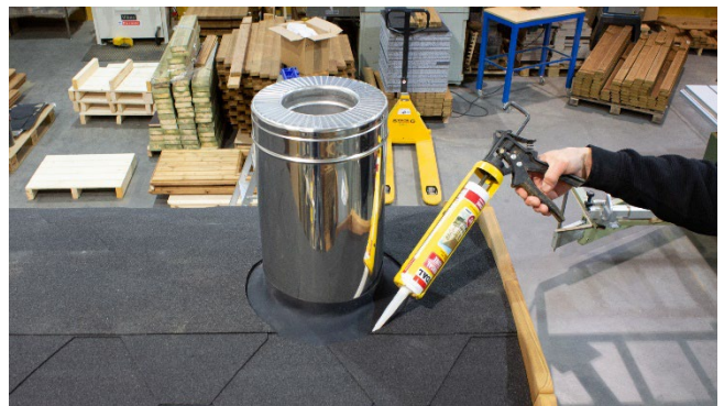
Silikoni on laitettava reunoihin kuvan mukaisesti.
