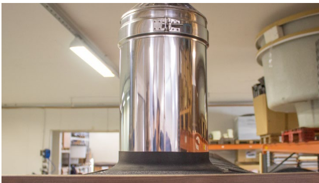
Säädä tiivistettä, kunnes sen kaltevuus on sama kuin kuvassa
