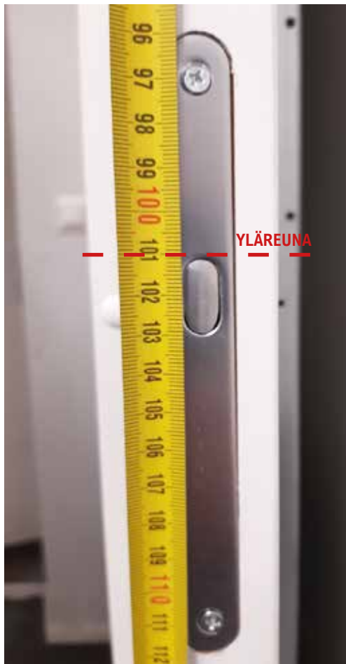
1B. Huom! Mitta suuntaa antava; riippuu lopullisesta oven korkeussäädöistä.
