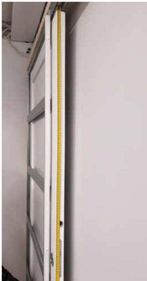
1A. Kun ovi on säädetty kohdalleen, mittaa yläkiskosta lukkokielekkeen yläreunan kohta.
