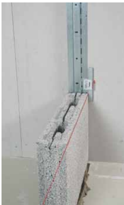
Leca® EasyLex profiiliin kiinnitettävään langanohjaimen on helppo kiinnittää linjalanka. Profiilin reiitys noudattaa harkon korkeusetenemää, jolloin langanohjain saadaan aina nopeasti oikeaan korkeuteen.
