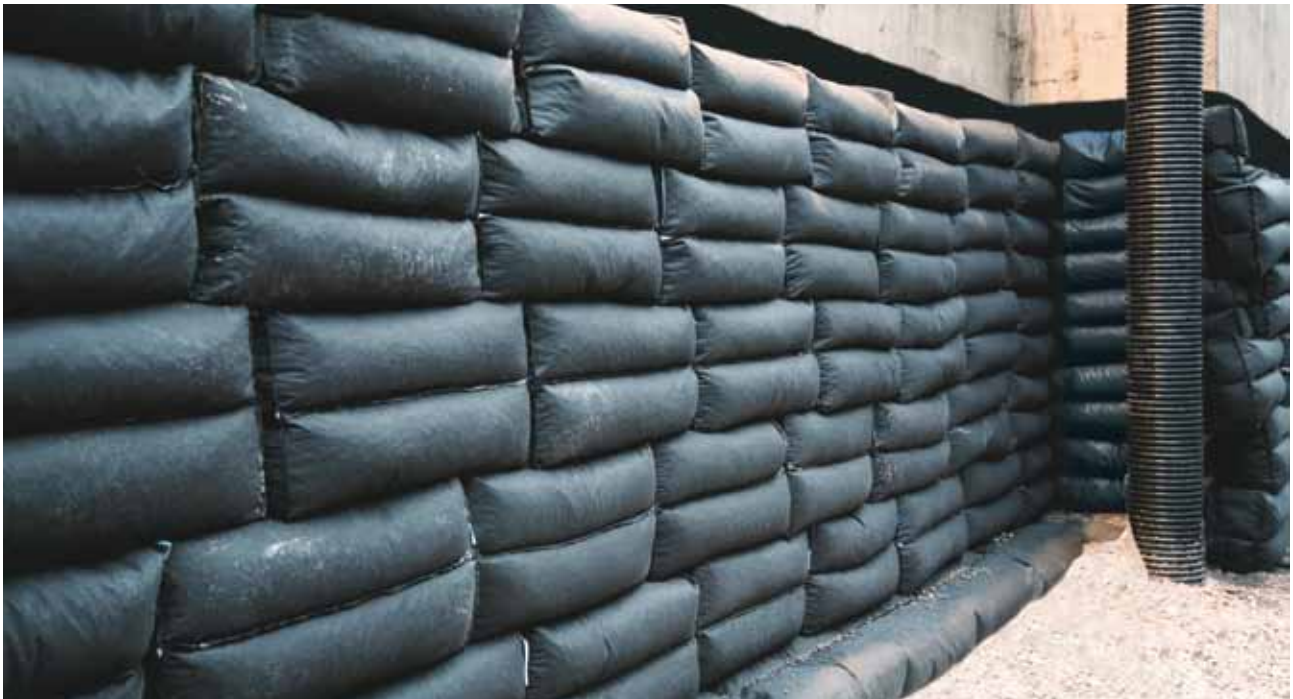
Maanpinnan alle jäävä seinä on eristetty bitumieristeellä, jonka ulkopuolelle on ladottu Geosäkkejä.
