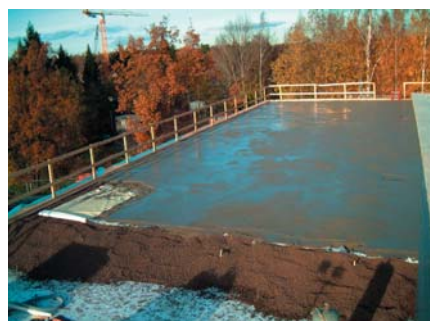
Kevytsoran päälle valettu betonilaatta.
