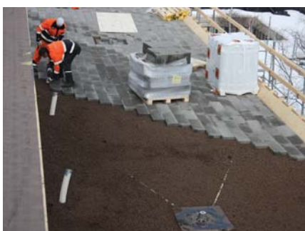
Vedeneristeen alusta voidaan tehdä betonilaatan sijasta ladottavilla Katelaaatoilla.
