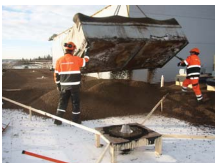
Kevytsora valutetaan nostolaatikosta ja tasataan korkorimojen avulla suunniteltuihin paksuuksiin.
