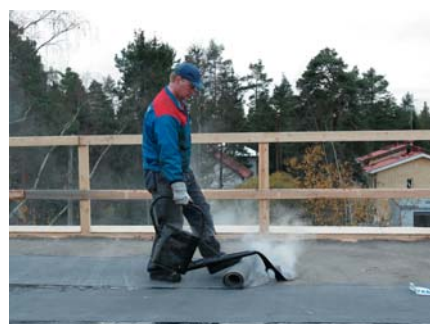
Bitumikermit asennetaan pintabetonin tai katelaaattojen päälle.
