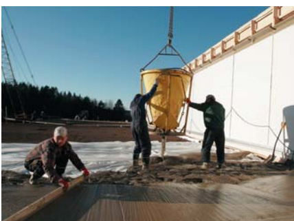
Ohut (20–40 mm) betonilaatta valetaan katteen alustaksi kevytsoran päälle. Kevytsoran ja betonin välissä käytetään suodatinkangasta tai sitkeää paperia.
