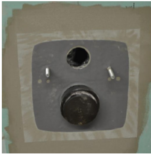
4E. MANSETIN ASENTAMINEN Paina mansetti välittömästi märkään vedeneristykseen ja varmista, että se peittää koko suojaussin. Tasaa mansetti ja peitä se neljännellä kerroksella veden- eristystä.
