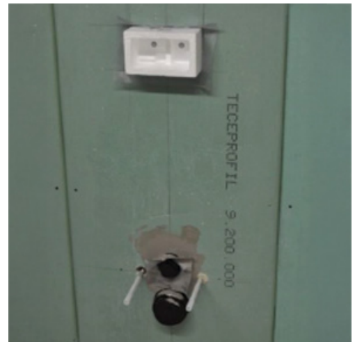
4. VEDENERISTYKSEN LEVITTÄMINEN Levitä vedeneristys oikeisiin kohtiin.
