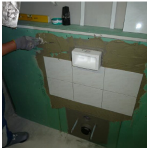
6. LAATOITUS 6A. ENSIMMÄINEN VAIHE Aloita laatoitus.
