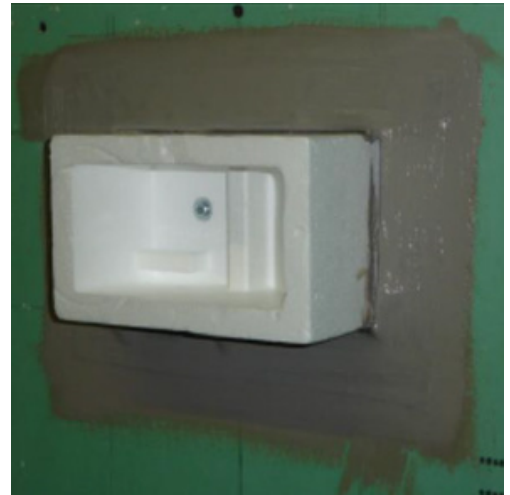
5D. KOLMAS VEDENERISTYSKERROS Levitä kolmas kerros samaan kohtaan 2,5 tunnin kuluttua.
