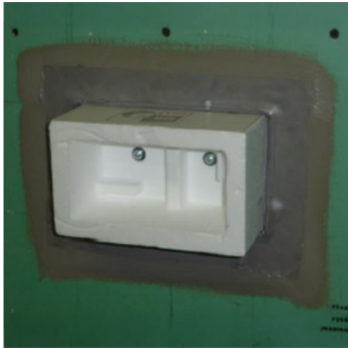
5B. LAIPAN ASENTAMINEN Paina laippa kosteaan vedeneristykseen ja tasoita erityisesti sisäreunasta.
