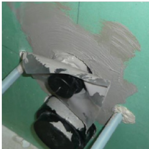
4A. HUUHTELUPUTKEN VEDENERISTYS Levitä vedeneristystä laajalle alueelle huhteluputken ympärille.
