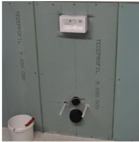
2. ETULEVYN ASENNUS Asenna etulevy, jossa on valmiiksi leikatut aukot – katso seuraavat kuvat
