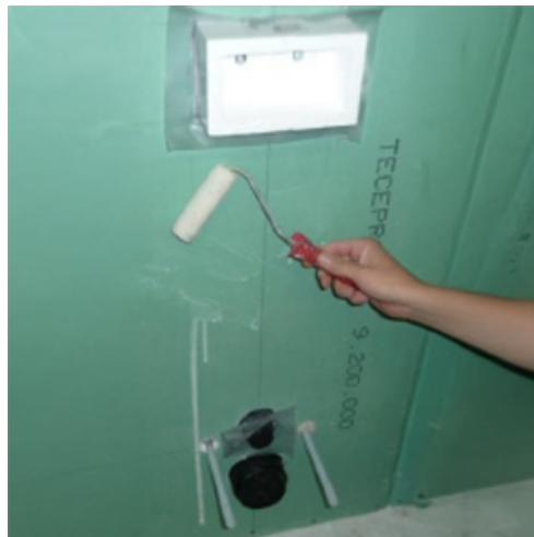
3. VEDENERISTYKSEN VALMISTELU Levitä primeri etulevyyn.
