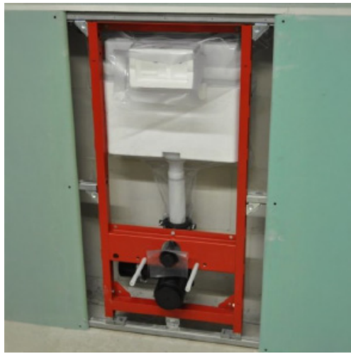
1. WC-MODULIN ASENNUS Asenna asennusteline seinään.
