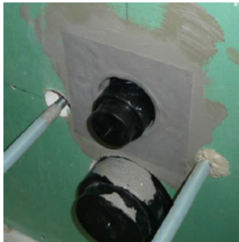
4B. LAIPAN ASENTAMINEN Paina laippa välittömästi paikoilleen ja tasoita se.
