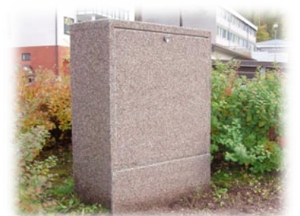
Kuva: Kivellä pinnoitettu teräksinen puhelin keskuskaappi.
