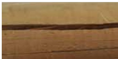
Halkeamat ja painaumat
