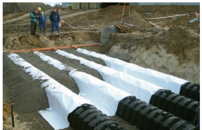
Tunnelimoduuleista syntyy aina tarvittavan kokoinen ja sijoituspaikan vaatimukset täyttävä ratkaisu.
