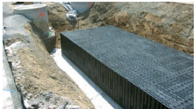
Hulevesikasetteja voidaan asentaa peräkkäin tai niitä voidaan pinota päällekkäin halutun kokoisen järjestelmän rakentamiseksi.
