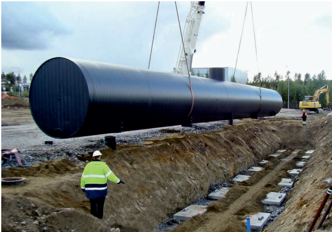
Metallisorvaamo sai luvun pihansa laajennukseen sillä ehdolla, että rakentaisi tontilleen hulevesisäiliön.
