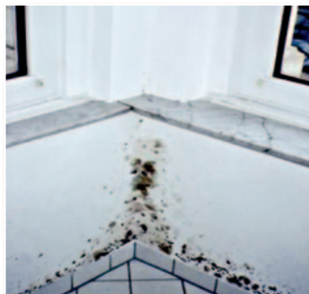
Ikkunaremontin yhteydessä ei ole kiinnitetty huomiota sisäilman kosteuden poistoon. Vain vuosi ikkunoiden vaihtamisesta tilanne näyttää tältä, koska sisäkosteus tiivistyi ikkunan vaihdon jälkeen kylmimpään kohtaan.
