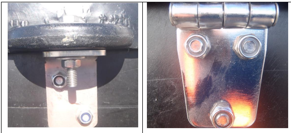
Kuva 7. Kannen kiinnitys huoltokaivon.
