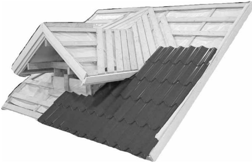
25a. Asenna räystäälle muotolevy, joka ulottuu lapeen suunnassa vähintään 400 mm jiirin loppukohdan yläpuolelle
