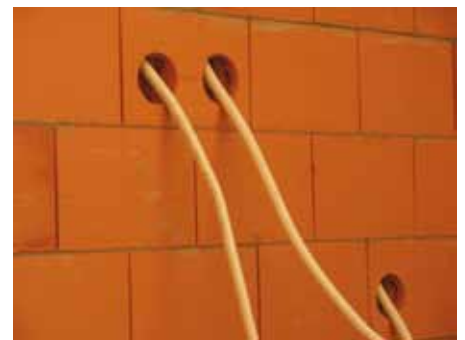
Runkotiilien suurien asennusreikien ansiosta sähköputkitukset on helppo toteuttaa ilman hankalia roilotuksia.
