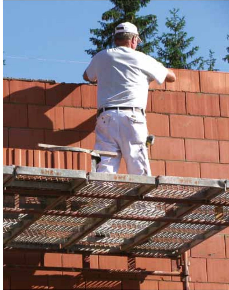
Terca-runkotiilien muuraus on nopeaa. Esim. 1-kerroksisen talon rungon muuraus sujuu jopa alle viikossa.
