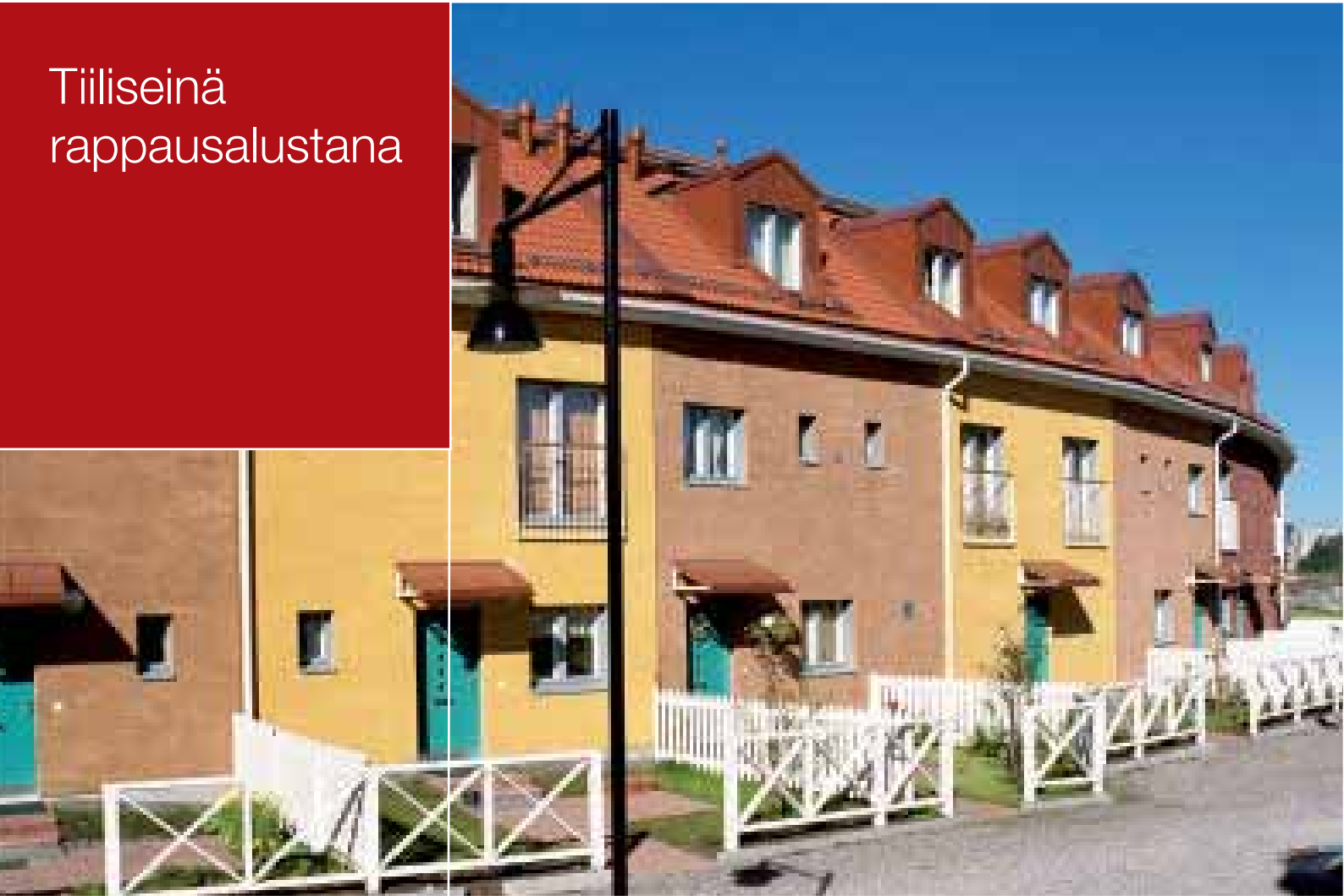
Tiili rappauksen alla: Keltaiseksi oksidoitu kuultorappaustiili Rappaus: Hierretty 1-kerrosrappaus
